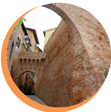
Uno scorcio di porta Maremmana in seguito agli interventi di ristrutturazione.
